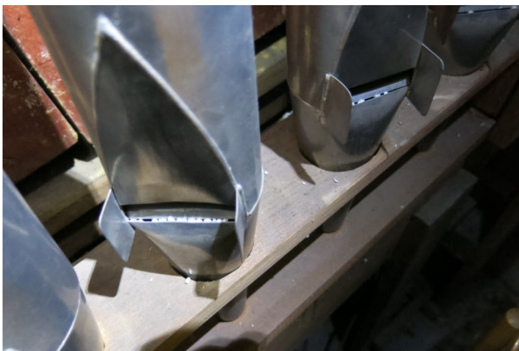
Kulki styropianu w szczelinach piszczałek.
